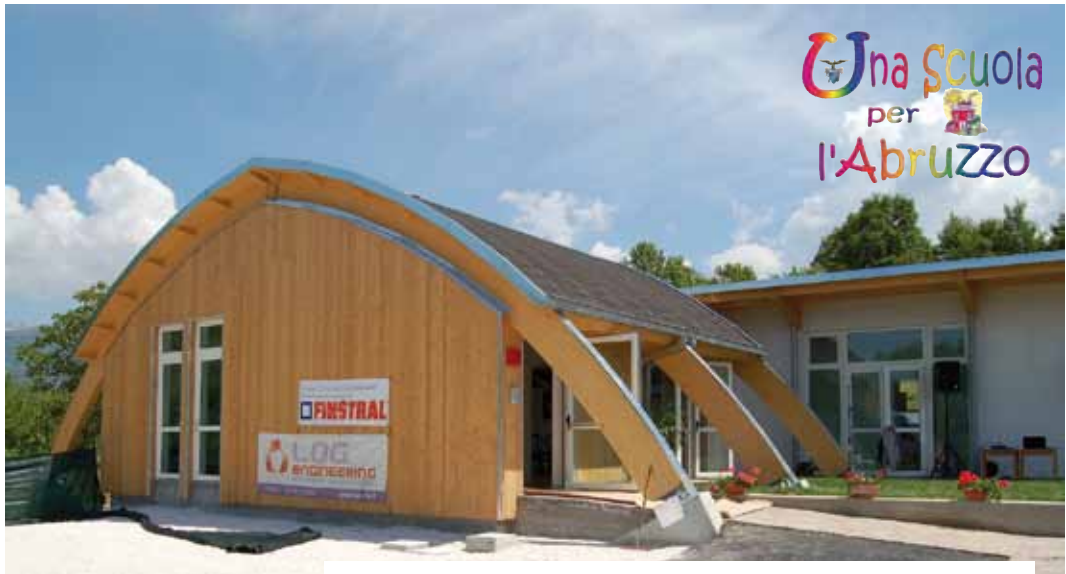
Il nuovo asilo a Gignano, ricostruito grazie al progetto SAT e inaugurato il 21 maggio scorso dopo soli 9 mesi dall'inizio dei lavori (foto Alma Mattedi)
